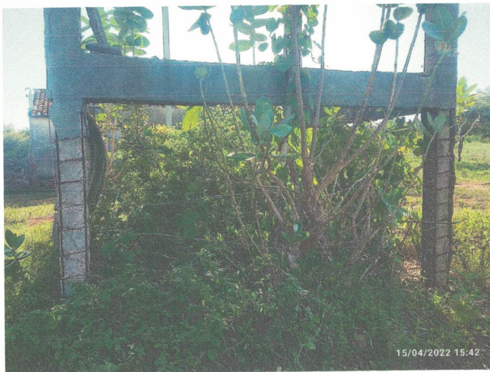
RELATÓRIO FOTOGRÁFICO SITUAÇÃO ATUAL DO RESERVATÓRIO
