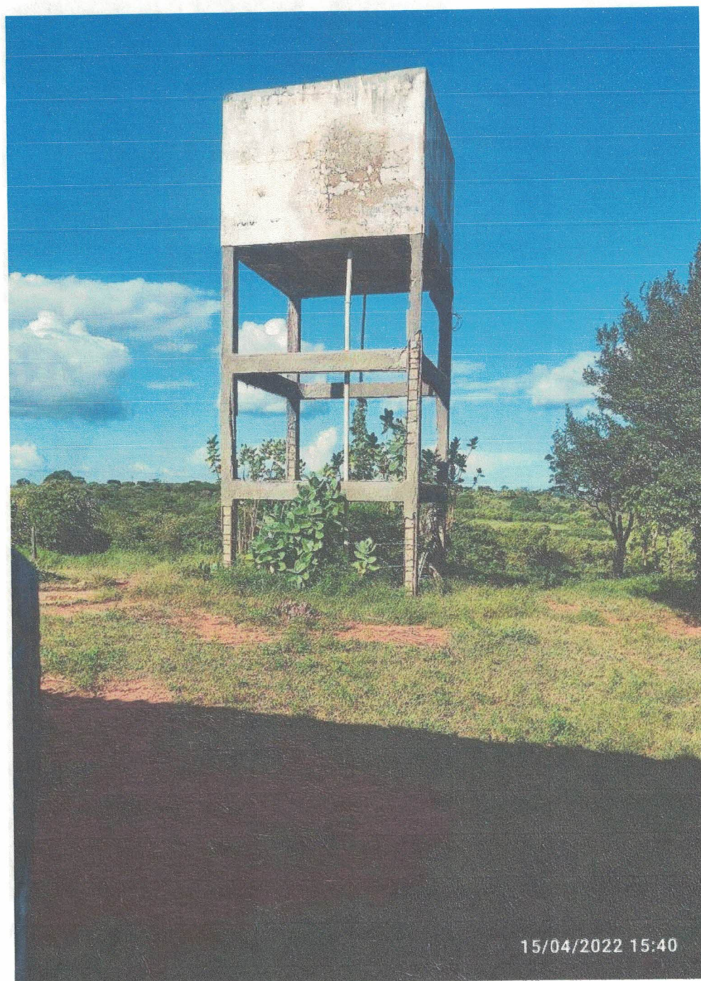
RELATÓRIO FOTOGRÁFICO SITUAÇÃO ATUAL DO RESERVATÓRIO
