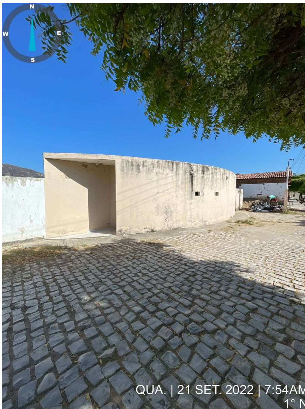
RELATÓRIO FOTOGRÁFICO SITUAÇÃO ATUAL DO ESTÁDIO BEIRA-RIO
