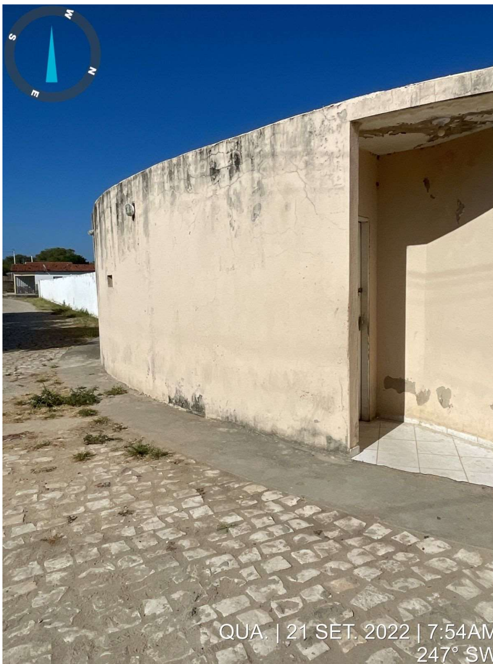
RELATÓRIO FOTOGRÁFICO SITUAÇÃO ATUAL DO ESTÁDIO BEIRA-RIO
