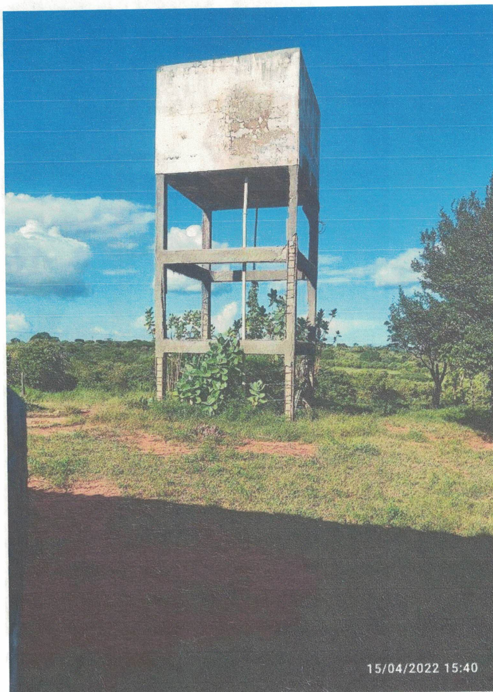
RELATÓRIO FOTOGRÁFICO SITUAÇÃO ATUAL DO RESERVATÓRIO
