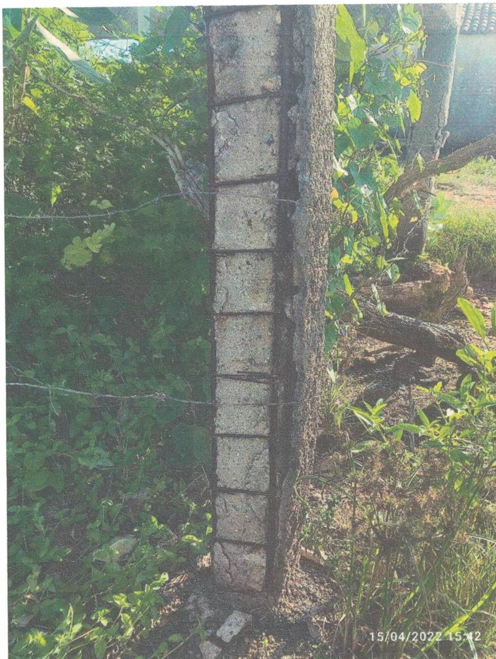
RELATÓRIO FOTOGRÁFICO SITUAÇÃO ATUAL DO RESERVATÓRIO
