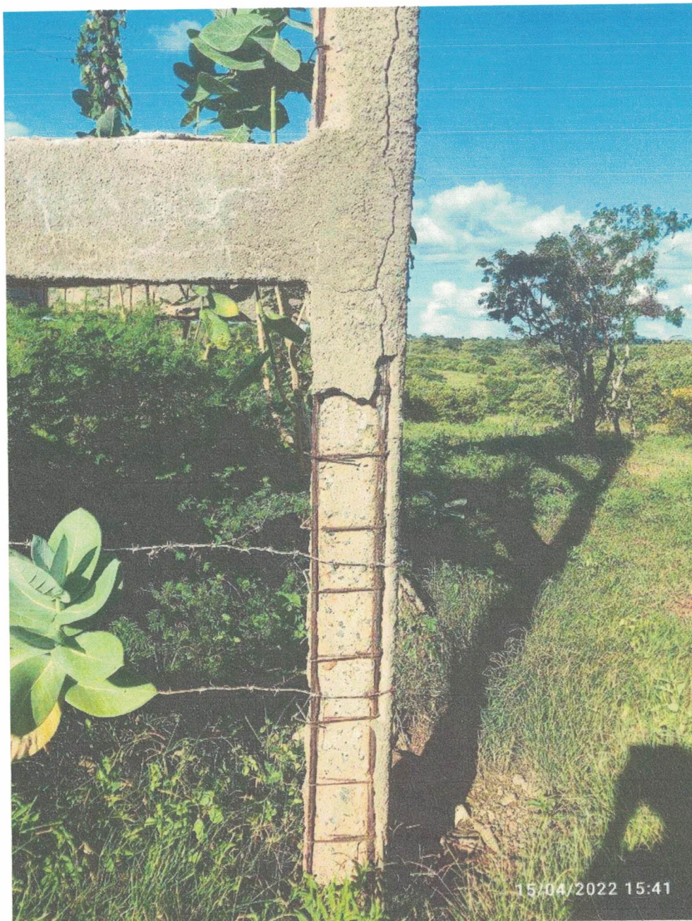
RELATÓRIO FOTOGRÁFICO SITUAÇÃO ATUAL DO RESERVATÓRIO
