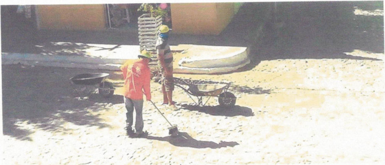
Imagem 01: Limpeza do pavimento
