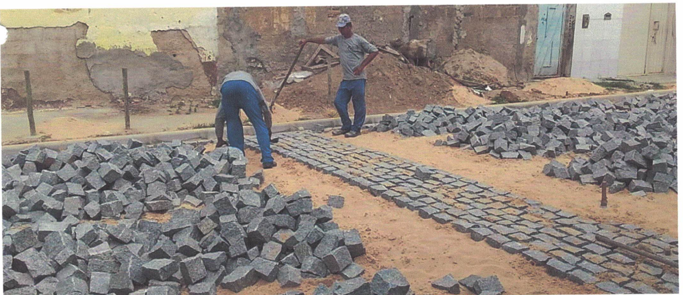
IMAGEM 04: ASSENTAMENTO DE PARALELEPÍEDOS
