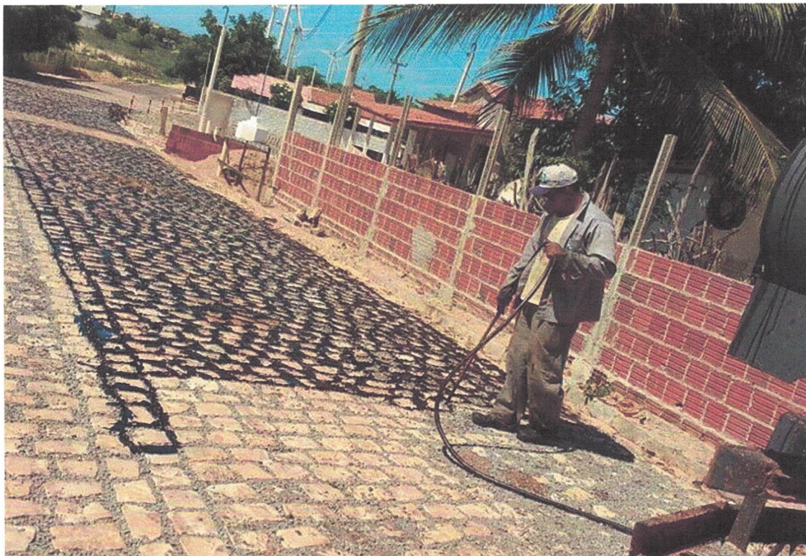
IMAGEM 05: REJUNTAMENTO DE PARALELEPÍPEDOS
