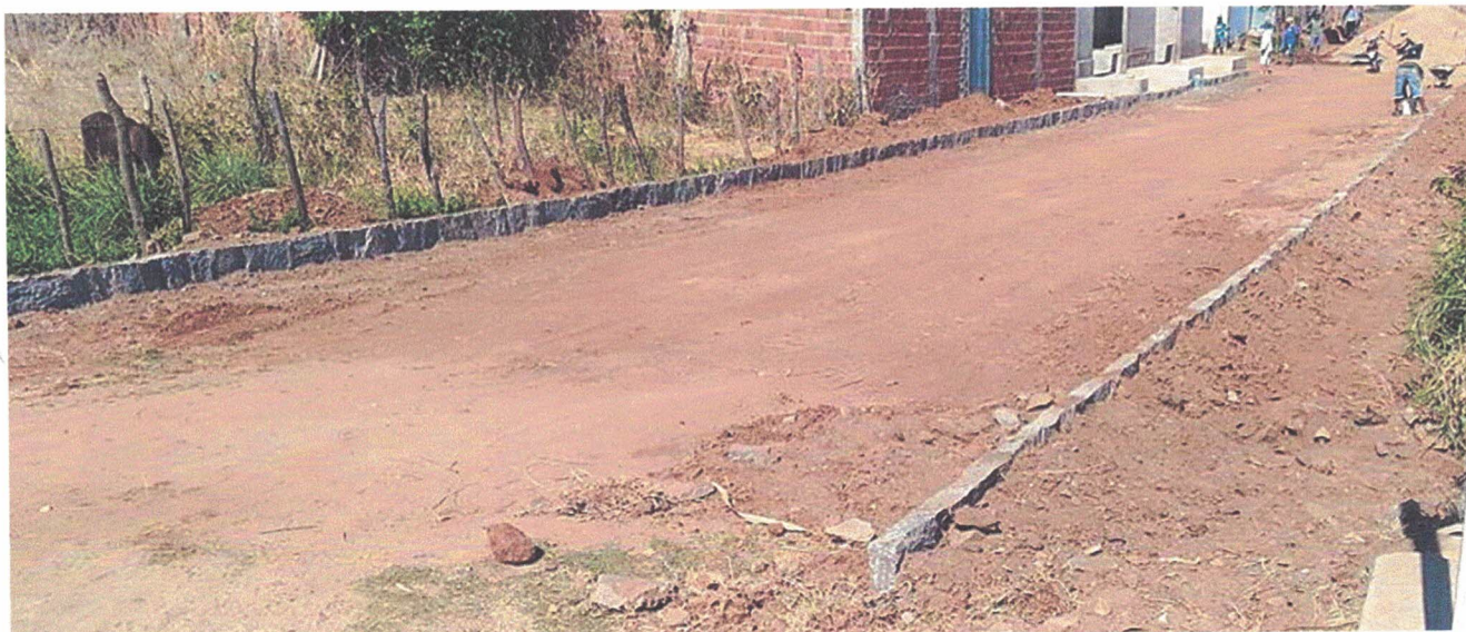
IMAGEM 04: EXECUÇÃO DE MEIO-FIO
