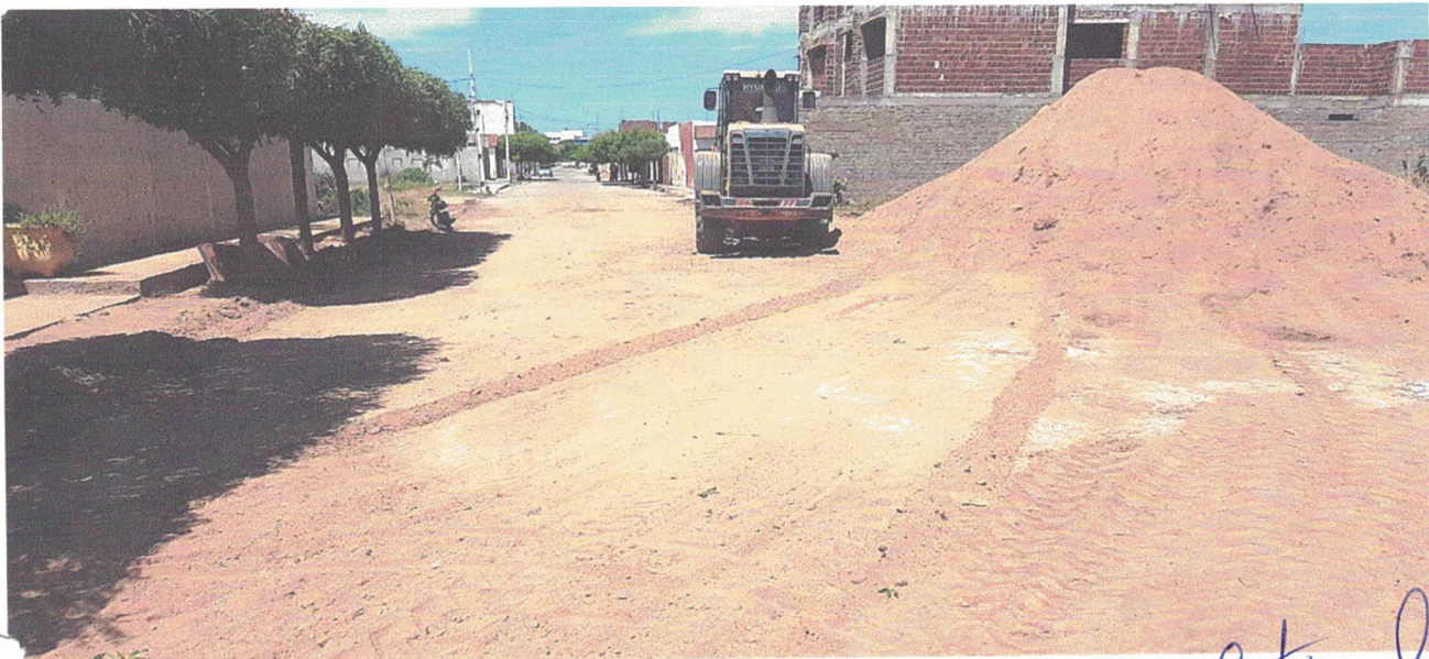
IMAGEM 02: CORTE DE TERRENO
