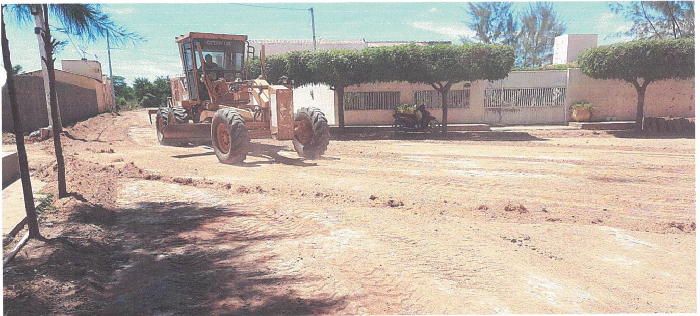
IMAGEM 03: EXECUÇÃO DA TERRAPLANAGEM DE RUA
