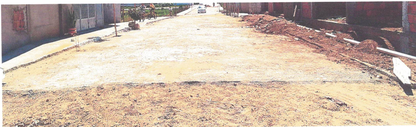
IMAGEM 07: TRAVAMENTO DE FINAL DE RUA COM MEIO FIO
