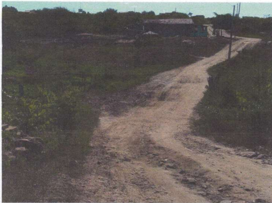
IMAGEM 08) LOCAL A SER CONSTRUÍDA A PASSAGEM MOLHADA DO SÍTIO JUAZEIRO.
