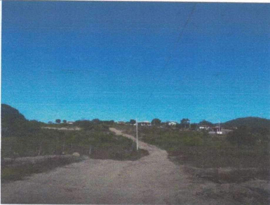
IMAGEM 09) LOCAL A SER CONSTRUÍDA A PASSAGEM MOLHADA DO SÍTIO JUAZEIRO.
