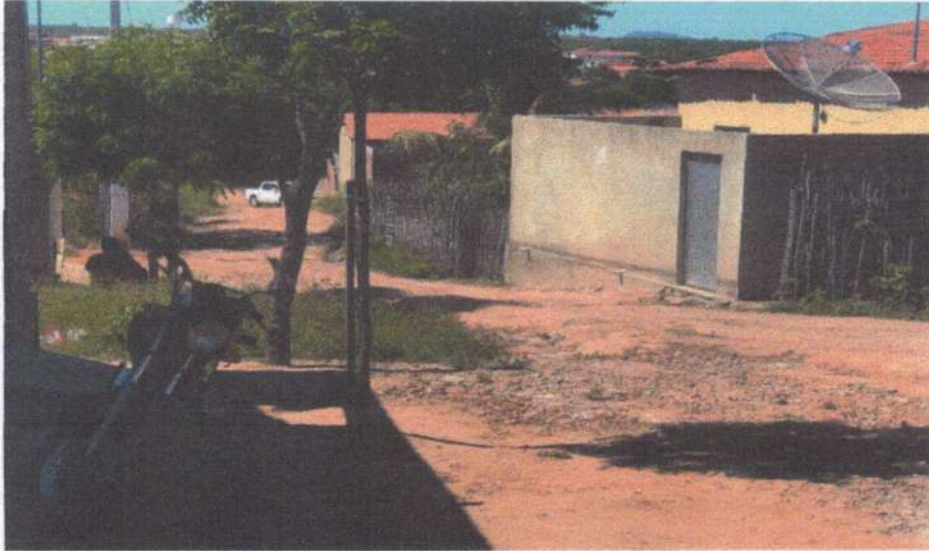
IMAGEM 01) RUAS A SEREM PAVIMENTADAS DA COMUNIDADE PÉ DE SERRA
