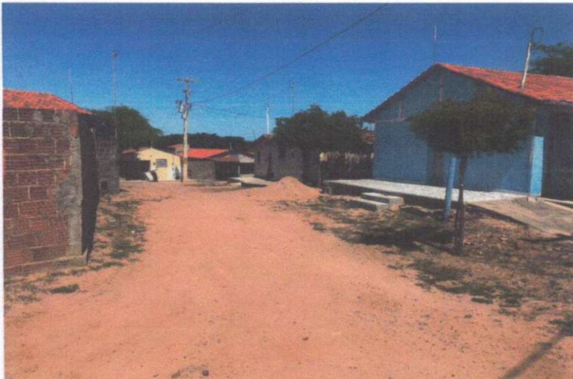
IMAGEM 06) RUAS A SEREM PAVIMENTADAS DA COMUNIDADE PÉ DE SERRA
